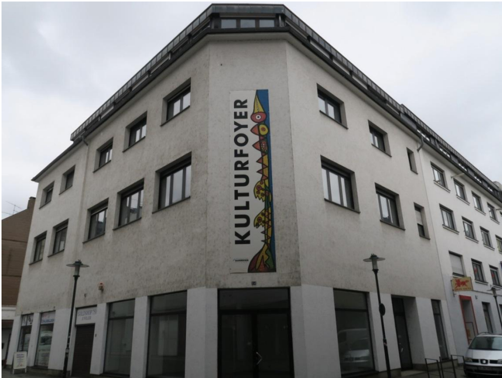
Ansicht von der Kaufhofpassage (Nutzung für ambulantes Wohnen)
